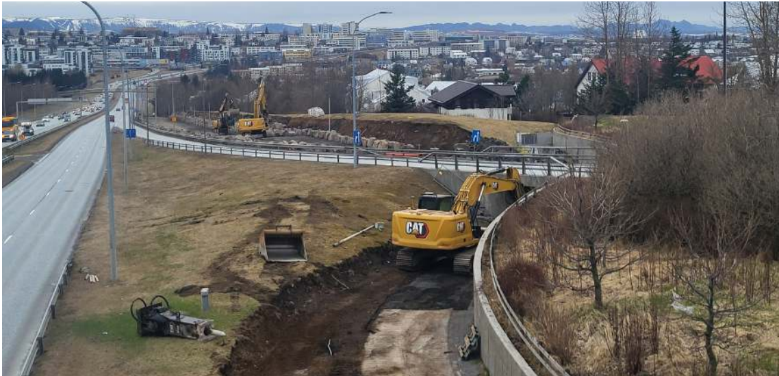
Framkvæmdir við nýjan stíg upp meðfram Suðurhlíðum stendur nú yfir, en þeim á að ljúka síðar í sumar.
