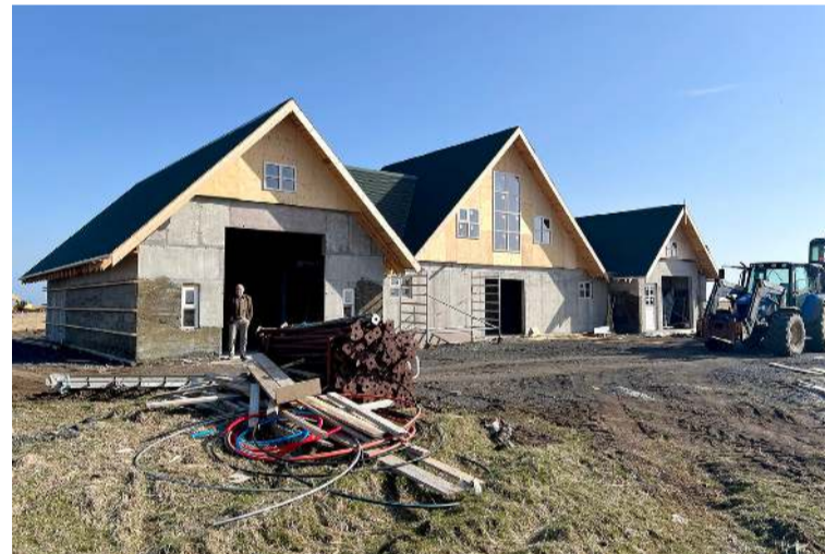
Einangrunar- og sæðingastöðin í Efra-Holtum er langt á veg komin. Byggð var tengibygging á milli tveggja gamla fjárhúsa sem voru á jörðinni.
