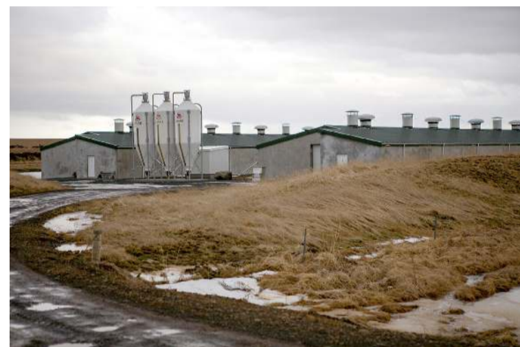
Tvö ný kjúklingahús voru tekin í notkun árið 2021 sem þrefaldaði framleiðslugetuna.
