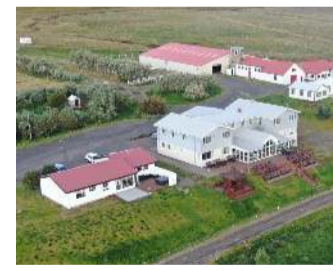
Til sölu Gauksmýri, póstrn: 531. Um er ræða alla jörðina ásamt öllum þeim húseignum sem eru á landareigninni, (fyrir utan hitaveituhús). Jörðin er áætluð um 650 hektarar. Hitaveita er á staðnum og eigin borhola fyrir kalt vatn. Tvö einbýlishús, 4 herbergja íbúð, 25 herbergja hótél, hesthús, hlaða, reiðhöll. Nánari upplýsingar: heimir@ fasteignaland.is
