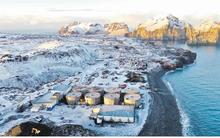
Fyrsta áfanga byggingar stöðvarinnar í Viðlagafjöru er að ljúka.
