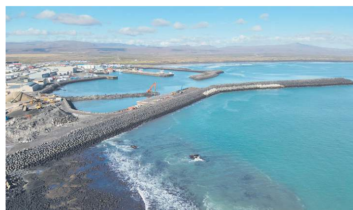
■ Framkvæmdum við nýja Suðurvararbyggju og athafnasvæði við hana lýkur í sumar.
