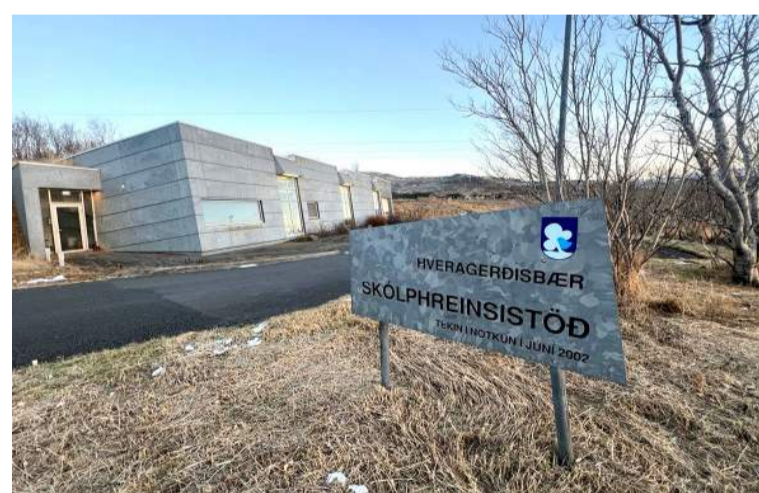
Fyrir tilstuðlan ESB-styrks til bættra vatnsgæða á Íslandi mun Hveragerðisbær nú hefjast handa við að bæta hreinsun fráveituvatns í Hveragerði. Mynd / ghp
