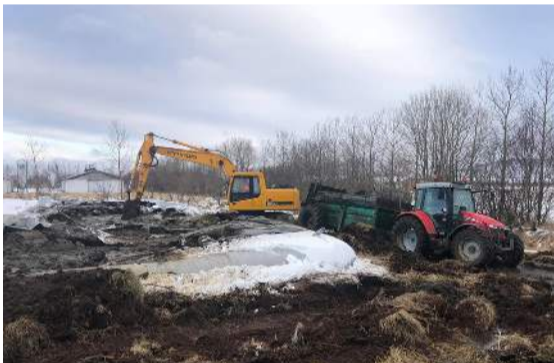
Endalok haugpokans. Á Facebook-síðu Hvanneyrarbúsins má sjá myndir sem rekja ferlið, en í stað hans var byggð ný hauggeymsla úr forsteyptum einingum.
