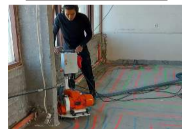
Gólfhiti, gólfþræsing fyrir 16 mm rör. Ryklaus gólfhitatræsing, verð á fermetra kr. 4.000 +vsk. Mætum hvert á land sem er, en fer þó eftir stærð verkefnis. Tilboð og upplýsingar á https://www.golffraeing.is s. 892-0808 - Oliver.
