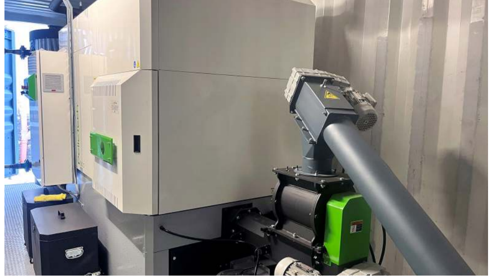
Peruketill. Með uppsetningu þeirra ásamt aðhaldsaðgerðum sveitarfélagsins Fjarðabyggðar tókst að komast hjá því að brenna olíu við hitaveituna.
