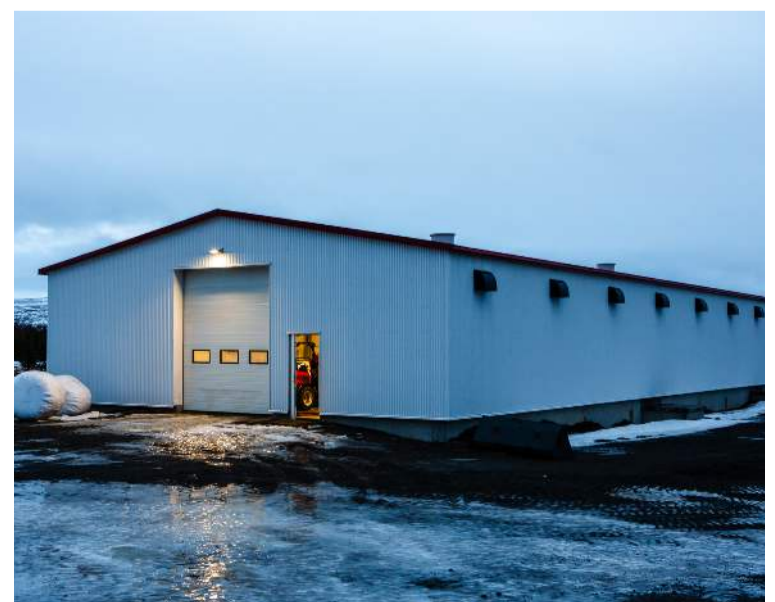
Nautahúsið er stálgrind klædd með yleiningum. Helmingurinn af byggingakostnaðinum liggur í því sem er neðanjarðar, eða steiptum haugkjallara.
