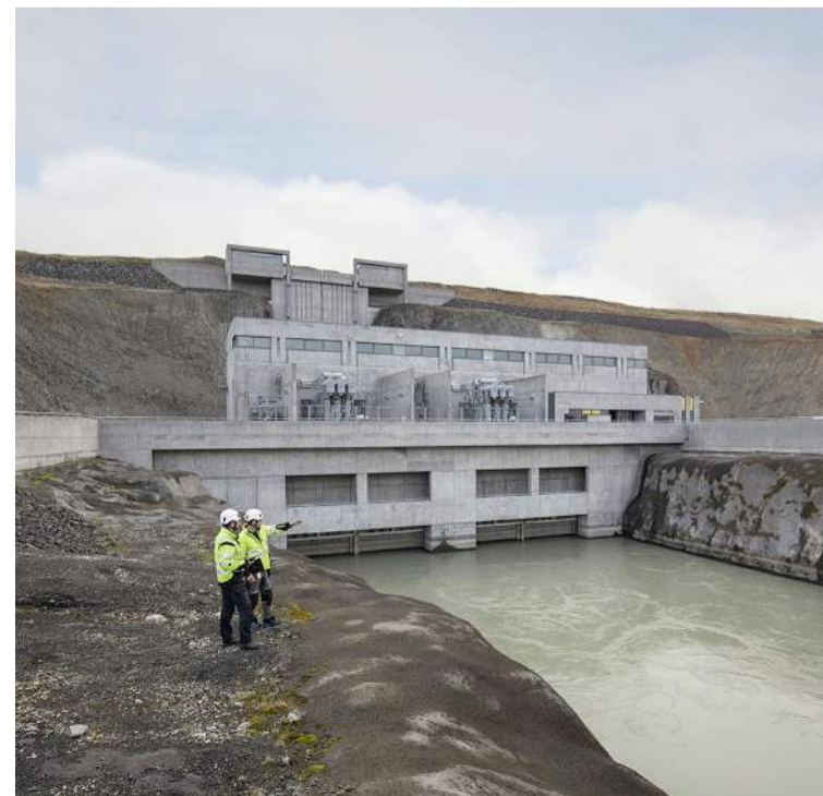
Búrfellslundur er ætlaður á stærsta vinnslusvæði Landsvirkjunar þar sem þegar eru sjö vatnsaflsstöðvar í rekstri. Búðarhálsstöð er ein þeirra, en hún er aðeins örfáa kílómetra í burtu. Mynd / Landsvirkjun
