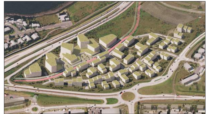
Íbúðabyggð í Arnarlandi muni aðlagja sig að hæð, landhalla og byggðamynstri nærliggjandi fjölbýlishúsabyggðar í Garðabæ og Kópavogi
