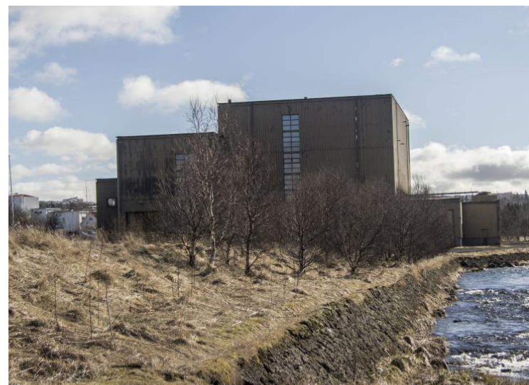
Toppstöðin í Elliðaárdal.
