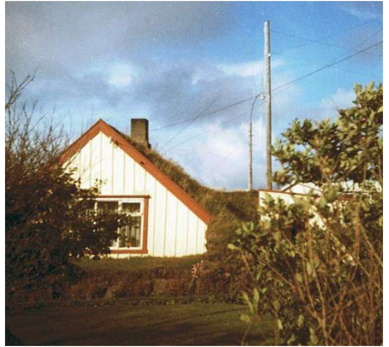
Litla-Brekka var rifin árið 1981
