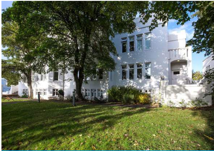
Sturluhallirnar við Laufásveg
