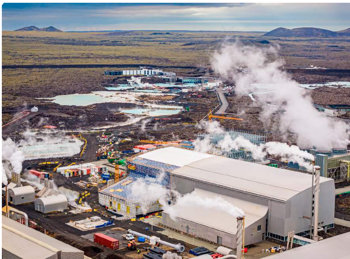
Framkvæmdir í Svartsengi ganga vel. Á þessari drónamynd Ragnars Axelssonar sést vel yfir í Bláa Lónið sem nýttir auðlindavökva orkuversins.
