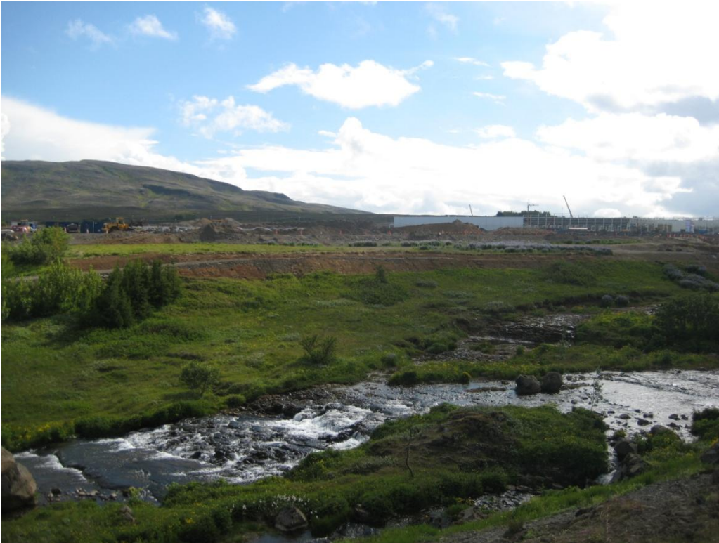
Mynd 14.1: Horft yfir fyrirhugað brúarstæði á Úlfarsá. Úlfarsfell í baksýn.
