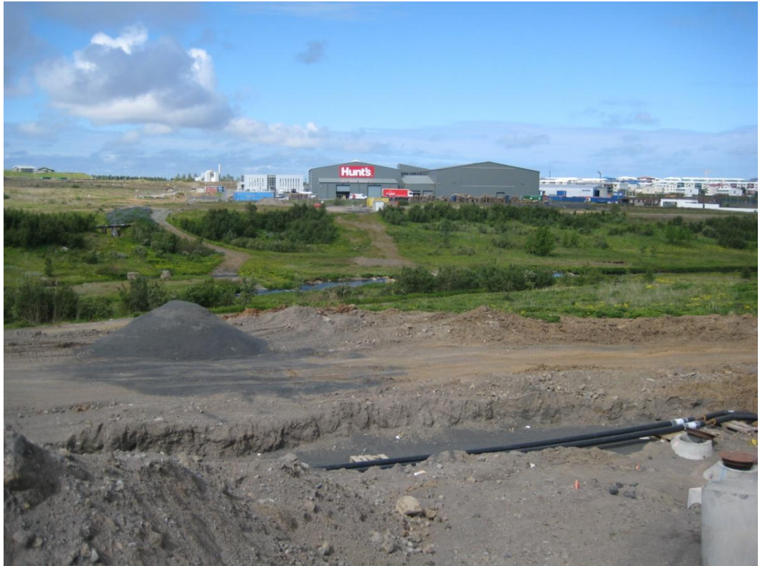
Mynd 5.1: Séð yfir fyrirhugað framkvæmdasvæði. Horft frá framkvæmdasvæði vegna verslunar og þjónustu við Vesturlandsveg.
